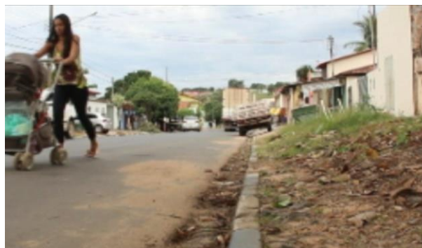
Figura 1: Frame da matéria realizada no município de Alto Araguaia sobre acessibilidade. Detalhe das calçadas inapropriadas para o deslocamento de pessoas.
