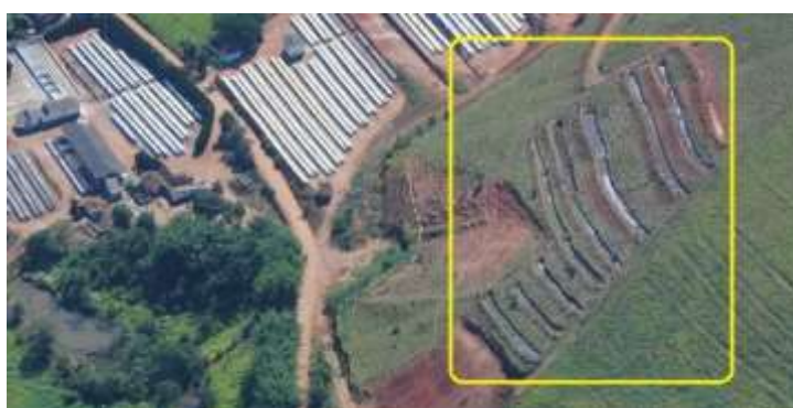
Figura 3. Imagem aérea das lagoas onde os efluentes são descartados após a etapa de aeração.
