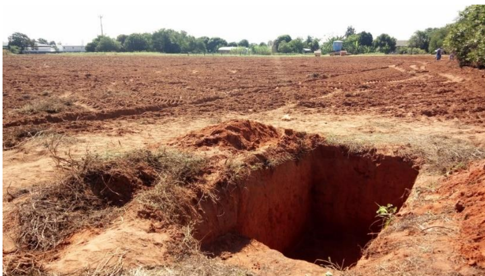
Figura 1. Visão geral da trincheira aberta para a realização do presente estudo.
