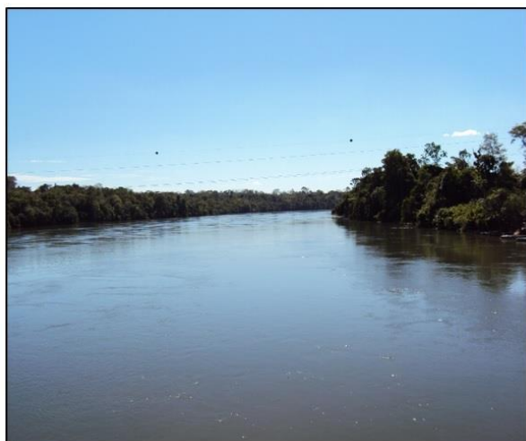
Figura 17 - Rio Arinos – Registro Feito sobre a ponte de concreto
