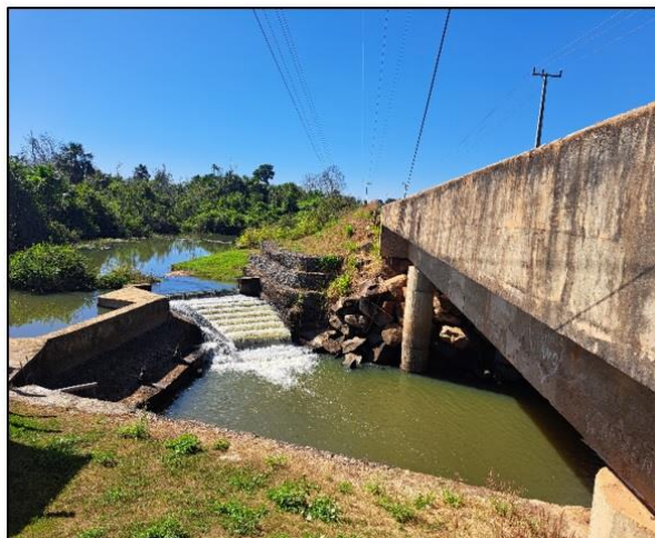
Figura 16 - Unidade de Captação de Água para Abastecimento Público – Córrego Alcebiades
