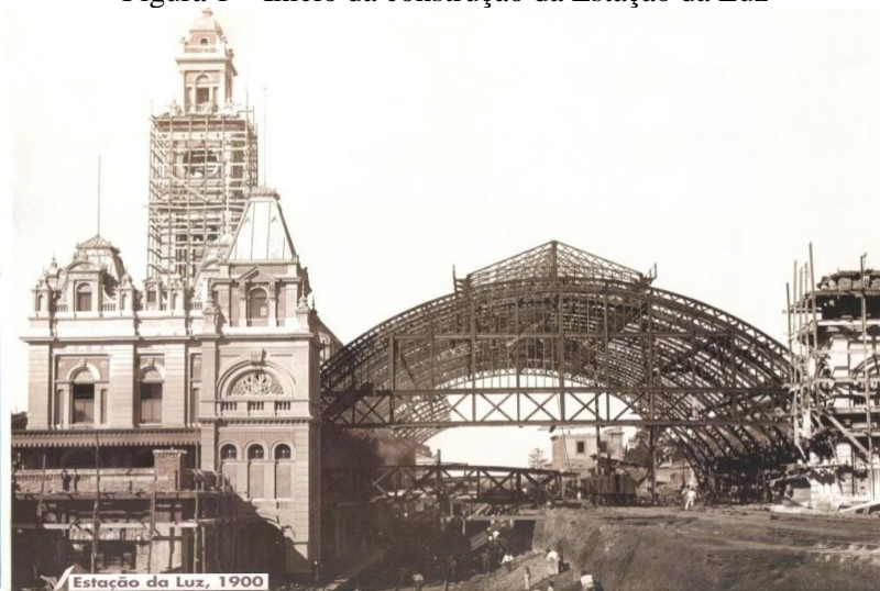
Figura 1 – Início da construção da Estação da Luz
