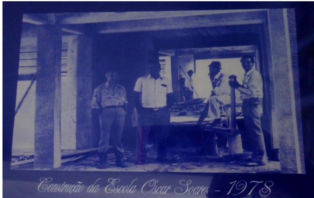
Figura 5 - Construindo a primeira escola de alvenaria, 1978.
