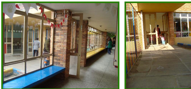
Imagem 3 - Corredor de circulação externo
