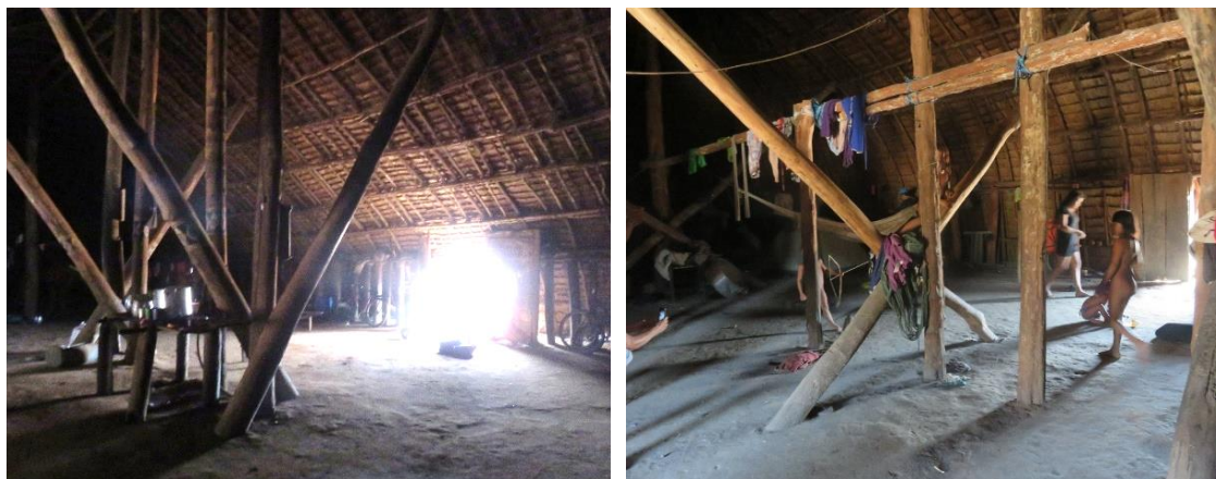
Figura 03 – Estrutura em “X” da casa Waurá e Kamayurá.
