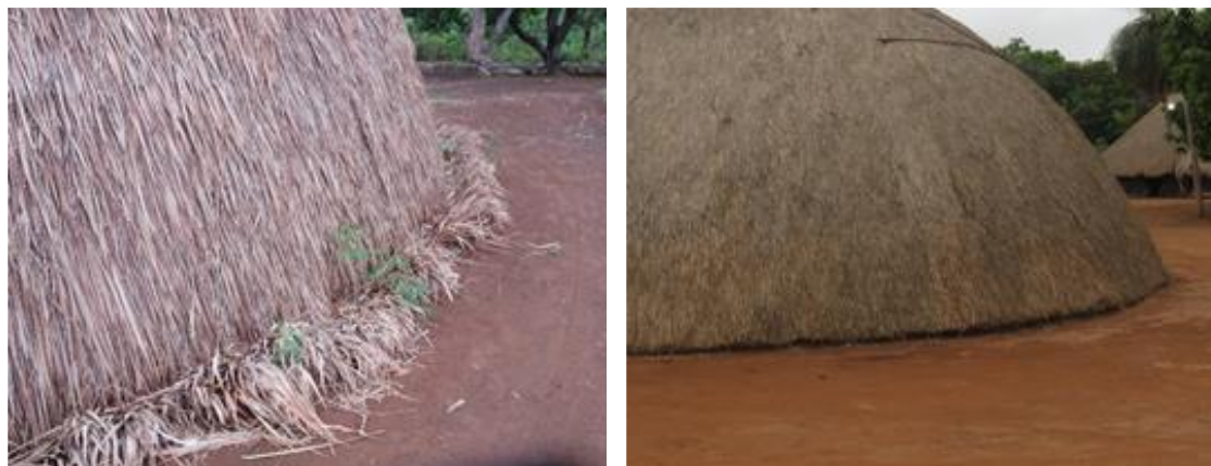
Figura 07 - Cobertura de sapé antes e depois de aparada
