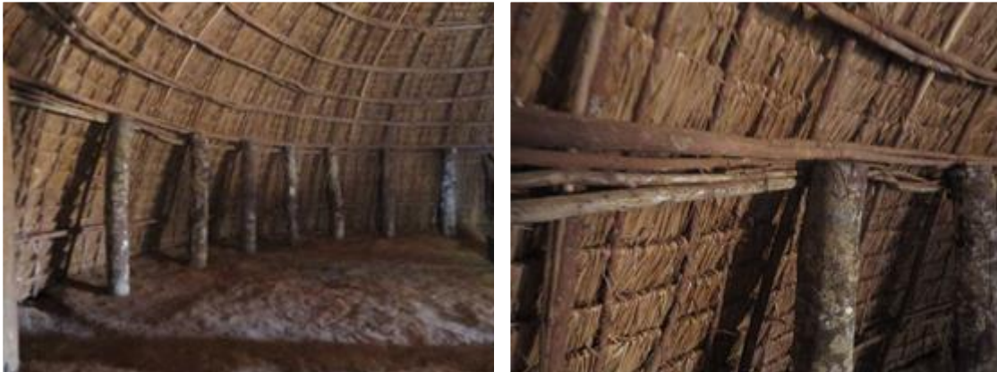
Figura 04 - Viga de feixes de madeira apoiada sobre os pilares periferais
