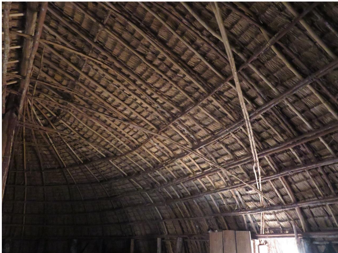
Figura 06 – vista interna da estrutura, com destaque para os espaçadores e contraventamento
