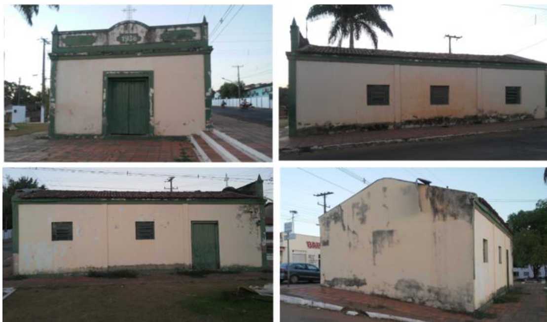
Figura 13: Fachadas da igreja
