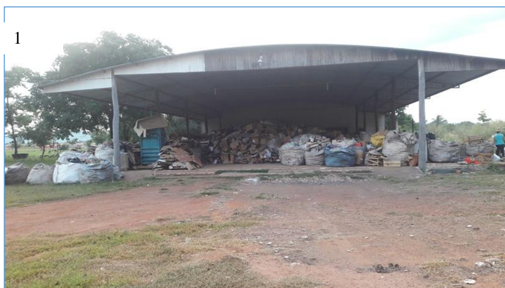
FOTO 1. Centro de triagem municipal de Cáceres
